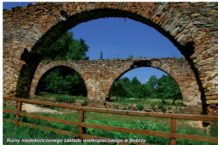
Ruiny niedokończonego zakładu wielkopiecowego w Bobrzy
